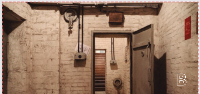
B Búnquer subterráneo.
